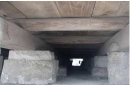
▲木制地垄防潮防水
